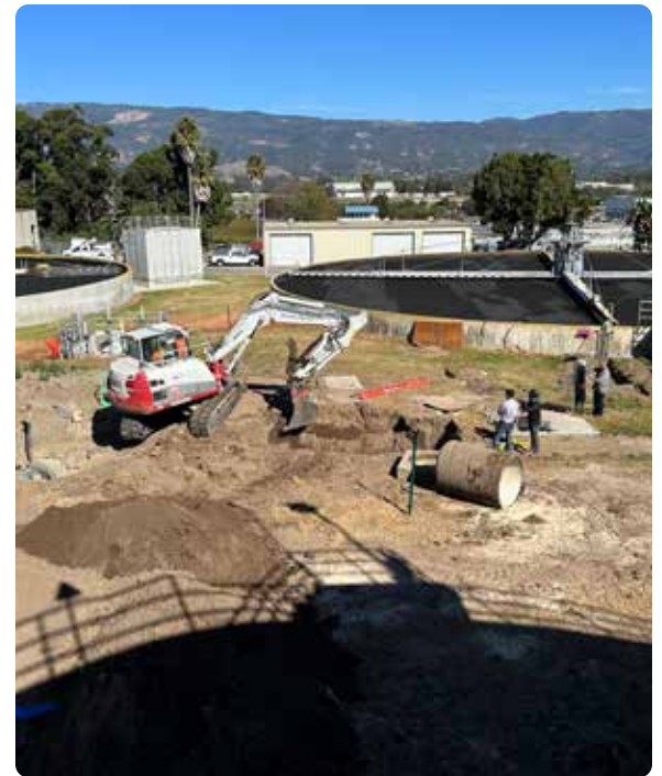
BESP Construction ▪ Construcción del BESP
